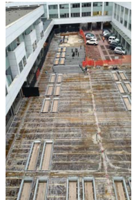
Risanamento piazzale da 3.000 mq
