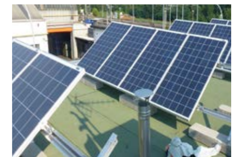
Realiz. Impianti Pannelli Solari
