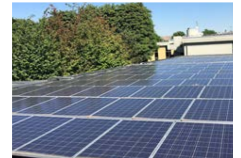
Realiz. Impianti Pannelli Solari
