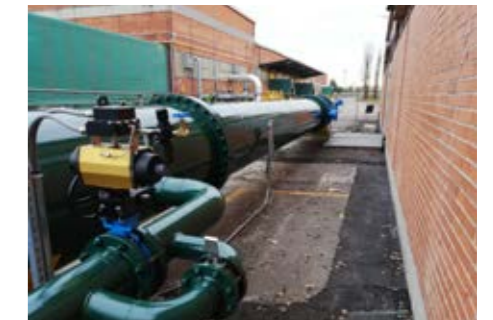
Realiz. Piping di grandi dimensioni
