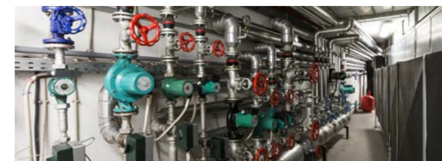
Realizzazione di centrale termofrigorifera - Aulla
