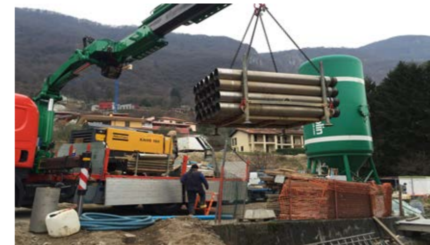
Realizzazione Impianti geotermici a bassa entalpia con sonde di profondità
