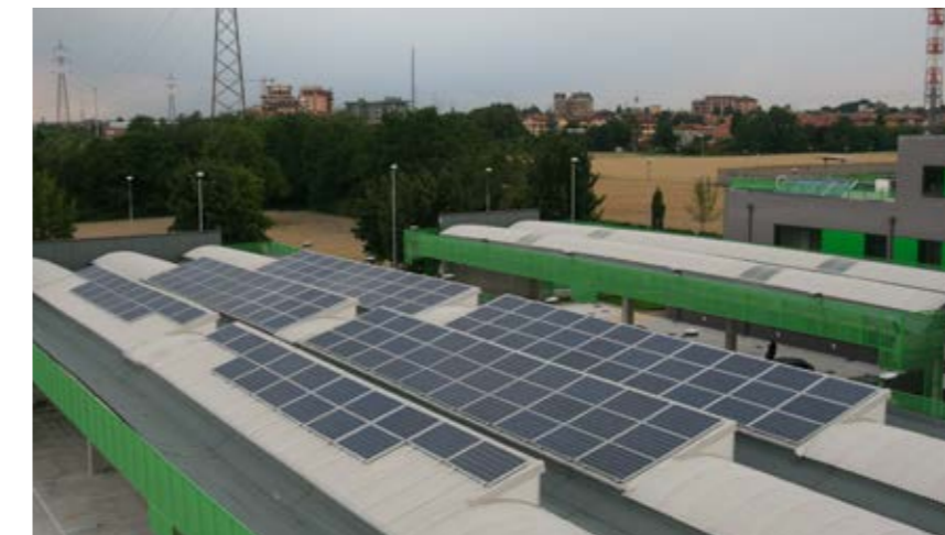
Realizzazione Impianti Pannelli Solari
