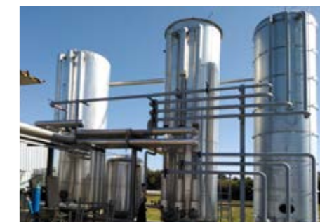
Realiz. Impianti Piping e Silos
