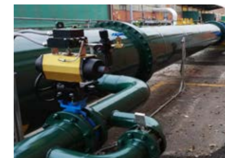
Realiz. piping di grandi dimensioni
